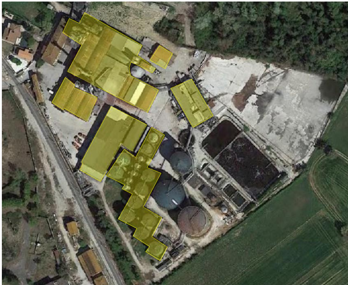
Figura 1: Corpi di fabbrica e serbatoi funzionali al processo produttivo
