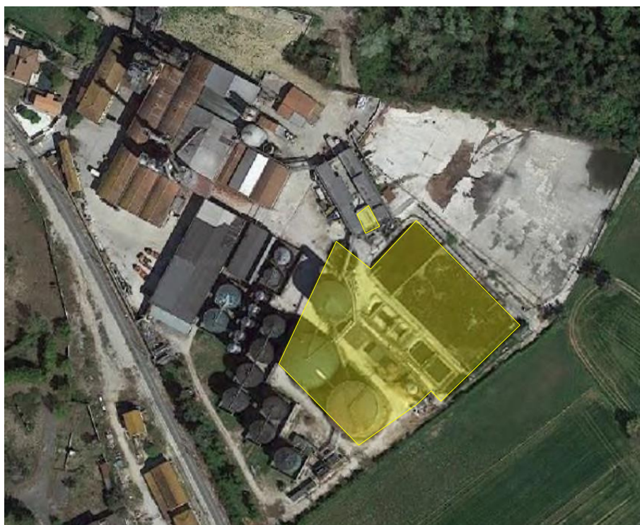
Figura 3: depuratore e locali tecnici, biodigestore e impianti correlati
